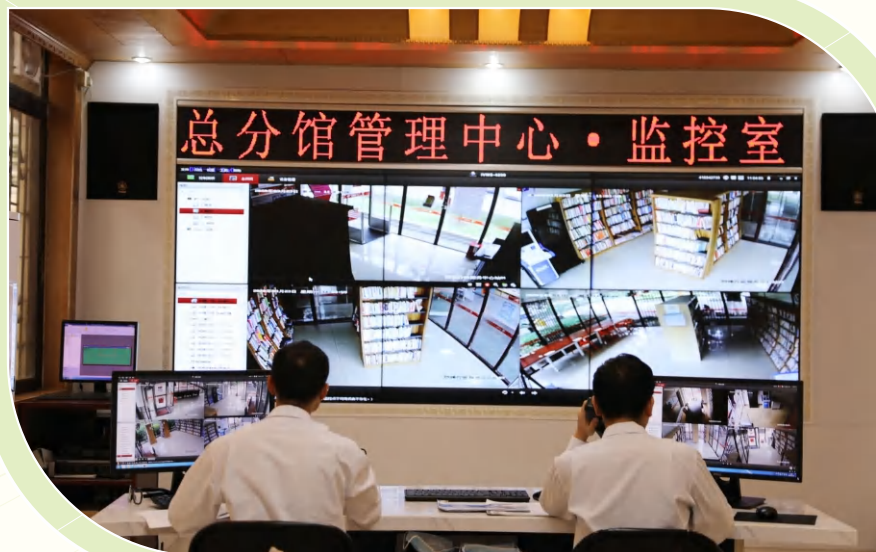
南海区图书馆总分馆监控中心由专人24小时在线实时监控，科学有效地完成巡查驿站情况、驿站故障维护等工作
